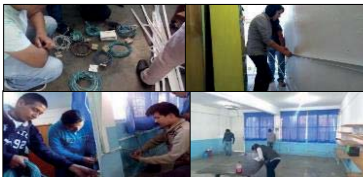
Figura 5. Instalación de cableado biblioteca y salones de clase. Elaboración propia.
