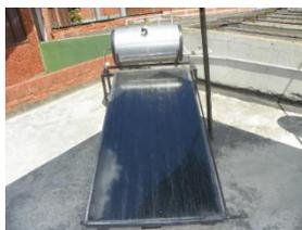
**Figura 1. Calentador solar de agua de tubos y placa metálica, para las duchas del gimnasio de la Facultad Tecnológica de la Universidad Distrital FJC**
